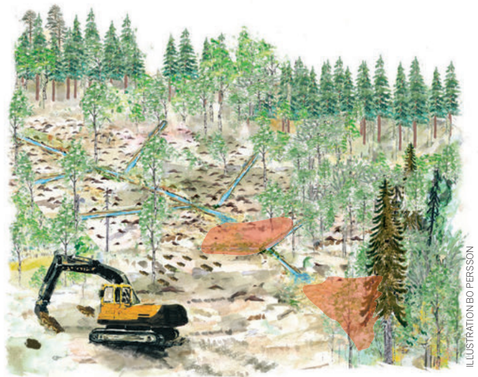
Grävmaskin anpassad med band höglägger på en skyddsdikad föryngringsyta. Skyddsdikena är avbrutna av översilningsområden (rödmarkerat i bild) i form av små våtmarker.
