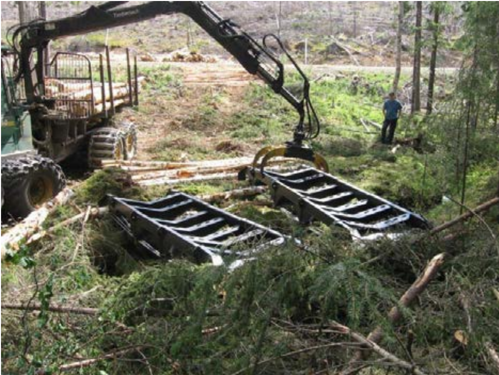
Bild 47. Stålbroad läggs ut över en bäck. Notera på- och avfart som har kavlats och risats. Förutom att skydda marken bidrar riset till att rensa hjulen/banden på maskinen. Det finns även möjlighet att montera uppsamlingsbaljor under broelementen. Foto: Per Simonsson.
