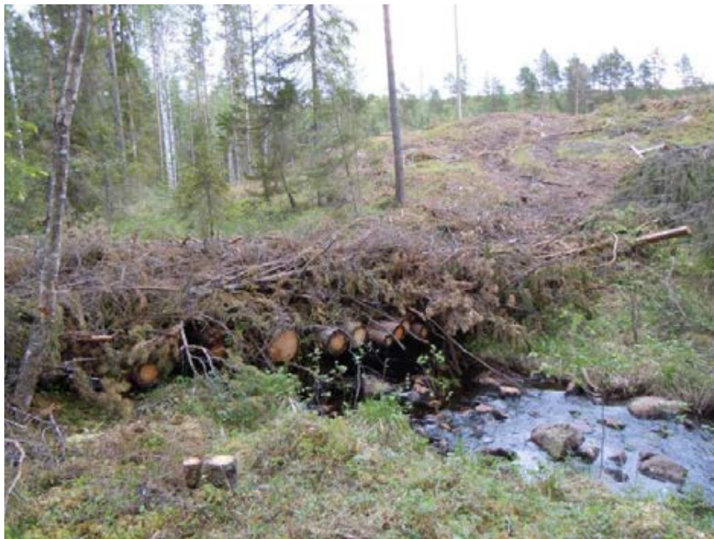
Bild 50. Ytterligare exempel på virkesbro, där mycket ris använts både på bron och i anslutning till bron. Foto: Börje Pettersson.
