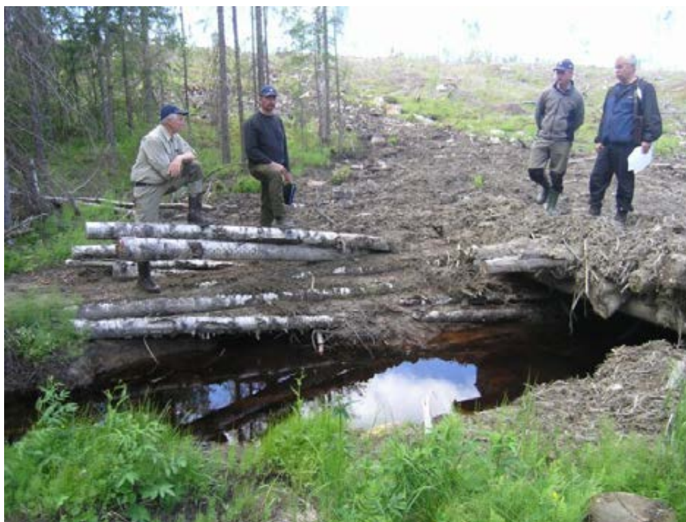
Bild 51. Ett exempel på överfart där det trots en rejäl bro blivit kraftig slamtransport ut i vattendraget. Omgivningen är brant och marken finjordsrik. Drivningen orsakade djupa körspår i sluttningen i vilka vatten och sediment runnit ner mot vattendraget. Finjordsrikt material som fortfarande ligger på stranden kommer också att spolats ut i vattnet vid regn och höglöden till dess att vegetation åter stabiliserar marken om några år. Noggrann planering av drivningsvägar är mycket viktig för att överfarten ska bli lyckad i sin helhet. På denna plats hade det troligen varit en bättre lösning att bygga en skogsbilväg över till andra sidan vattendraget. Foto: Per Simonsson.
