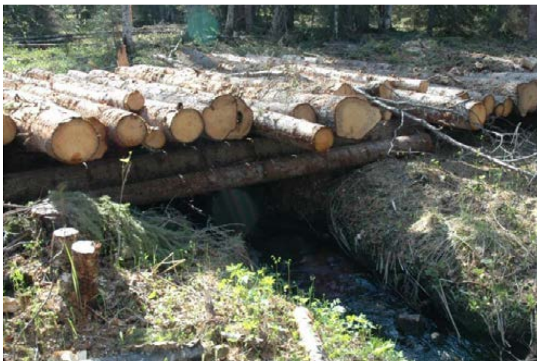
Bild 49. Exempel på virkesbro över en liten bäck. Foto: Leif Jougda.
