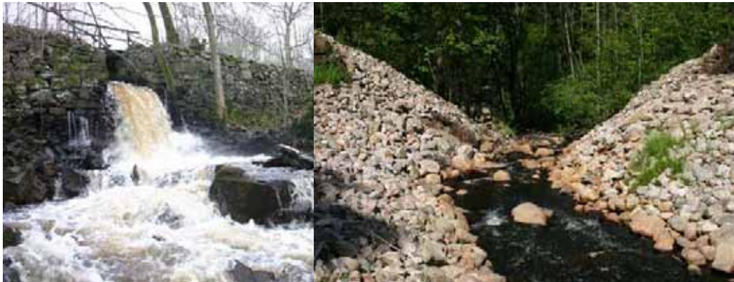
Figur 15. Hovgårdsdammen i Varberg med dammen intakt i vänster bild och dammen utriven i den högra, som dessutom är tagen uppifrån. Den här åtgärden är mer vanlig i mindre vattendrag, men naturligtvis möjlig i även älvar.
