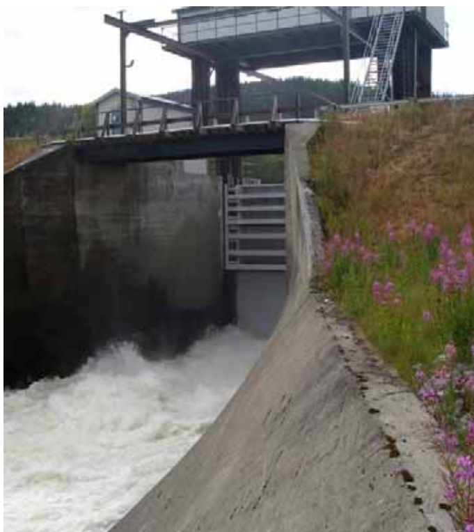
Figur 8. Regleringsutskovet vid Vojmsjödammen som exempel på både möjligheten att helt stänga vattentillförseln och dessutom skapats till ett definitivt vandringshinder där fisk förut vandrade fritt.
