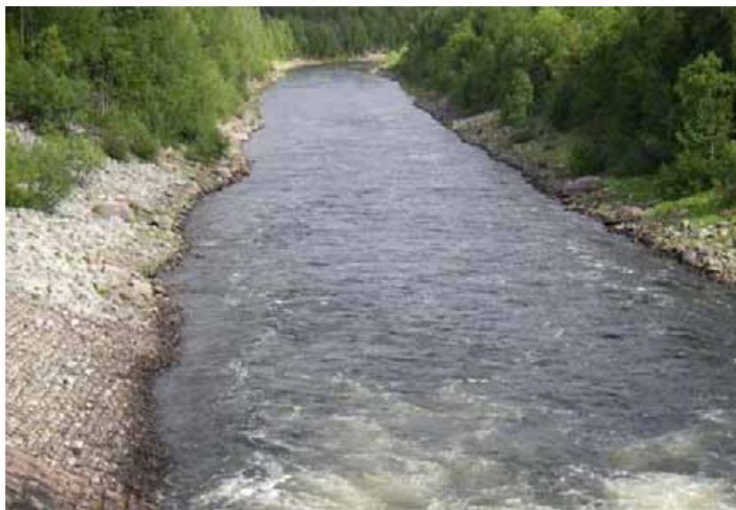
Figur 20. Den nedsänkta utloppskanalen ur Vojsjödammen har en ganska jämn kant utan vegetation närmast vattnet. Eftersom mätpunkten för minimitappningen ligger nedströms kanalen kan hela kanalen, som är mer än 1,5 km, i princip vara torr.
