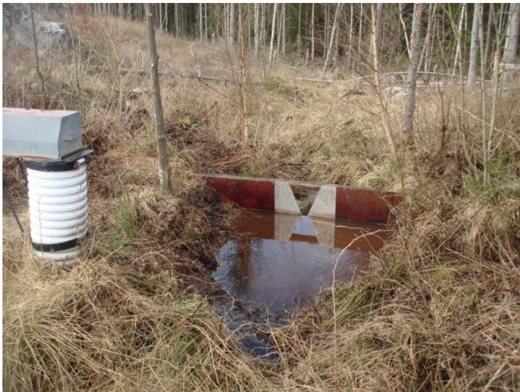
Figur 5. Den hydrologiska mätdammen vid utloppspunkten för avrinningsområde Ni10. Till vänster om mätdammen skymtar den automatiska pegelskrivaren som kontinuerligt registrerar vattenståndet. Pegelskrivaren är kopplad till en flottör installerad i ett vertikalt rör (det vita röret) som i sin tur är kopplat till ett annat rör som leder in under dammen (detta rör har ett skydd vid rörets utlopp för att förhindra igensättning). Foto: Florinne Floruta.
