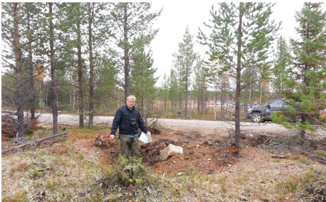
Bild 8. Fångstgrop skadad vid vägarbete.
