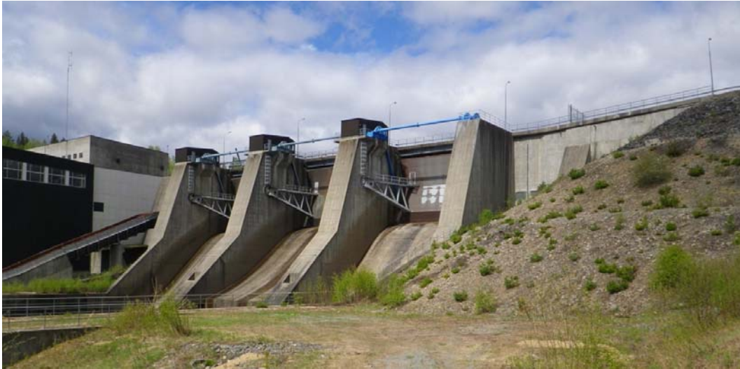
Figur 24. Moforsens kraftverk sett snett nedifrån 2011.
