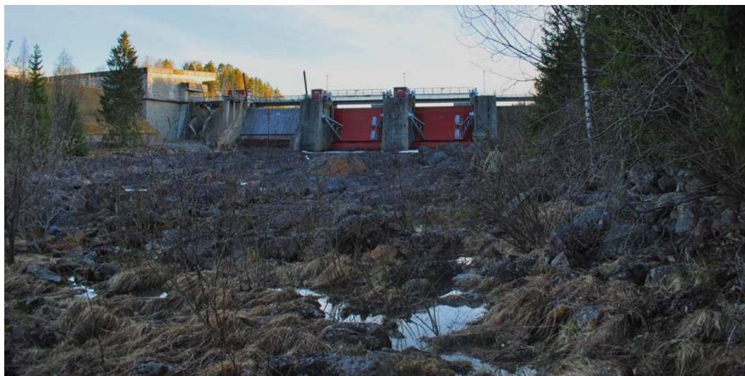
Figur 25. Hjälta kraftverk sett nedifrån 2011.
