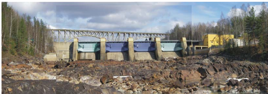
Figur 23. Forsmo kraftverk sett nedifrån 2011.
