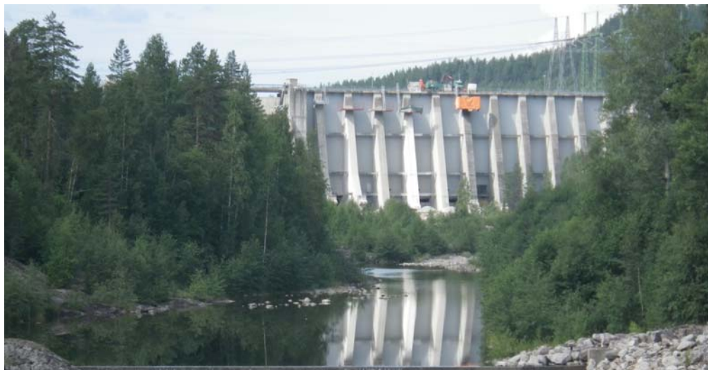
Figur 28. Ramsele kraftverk sett nedifrån 2011.
